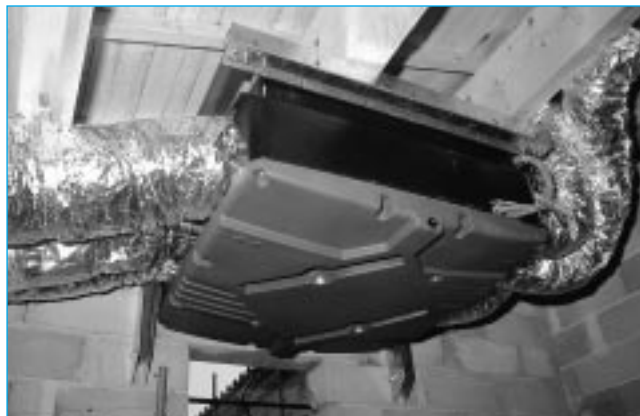
Centrale montée sur un kit de fixation mural →
